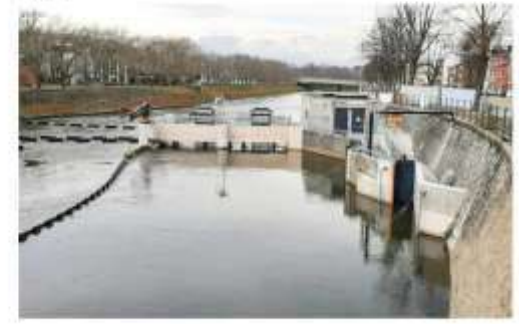
Voici la centrale hydroélectrique des Grosses Battes, sur l'Ourthe, à Chênée inaugurée par le Ministre wallon de l'Énergie, Philippe Henry ainsi que par les deux acteurs concernés: la SOFICO, le SPW Mobilité et Infrastructures et la SOE. H05e
